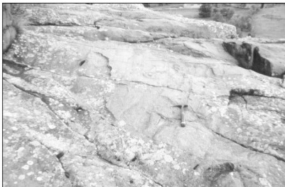
Photo 18 - Plate-forme prismée du premier niveau.
